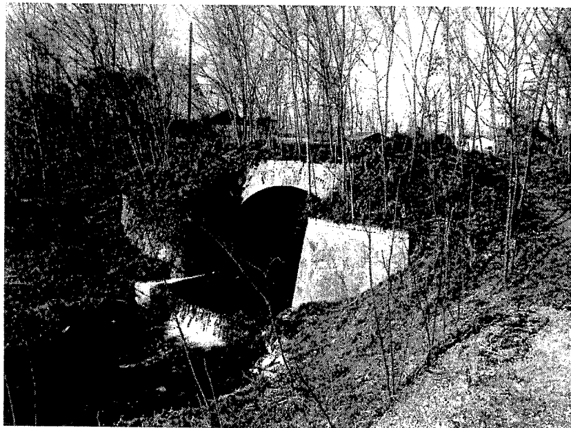
Scolo Riale Manufatto di attraversamento dell'Ostiglia (vista da valle)
